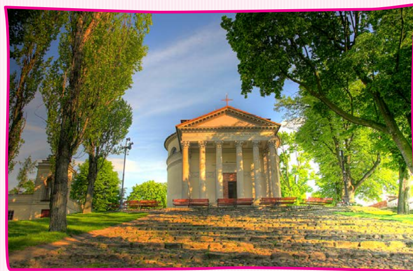
Kościół pw. Wniebowzięcia NMP fot. K. Wójcik
